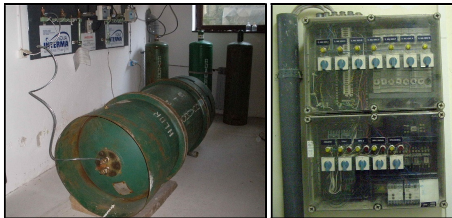
Слика 8 - Гасни хлоринатор у п.с. „Љубераћа“
